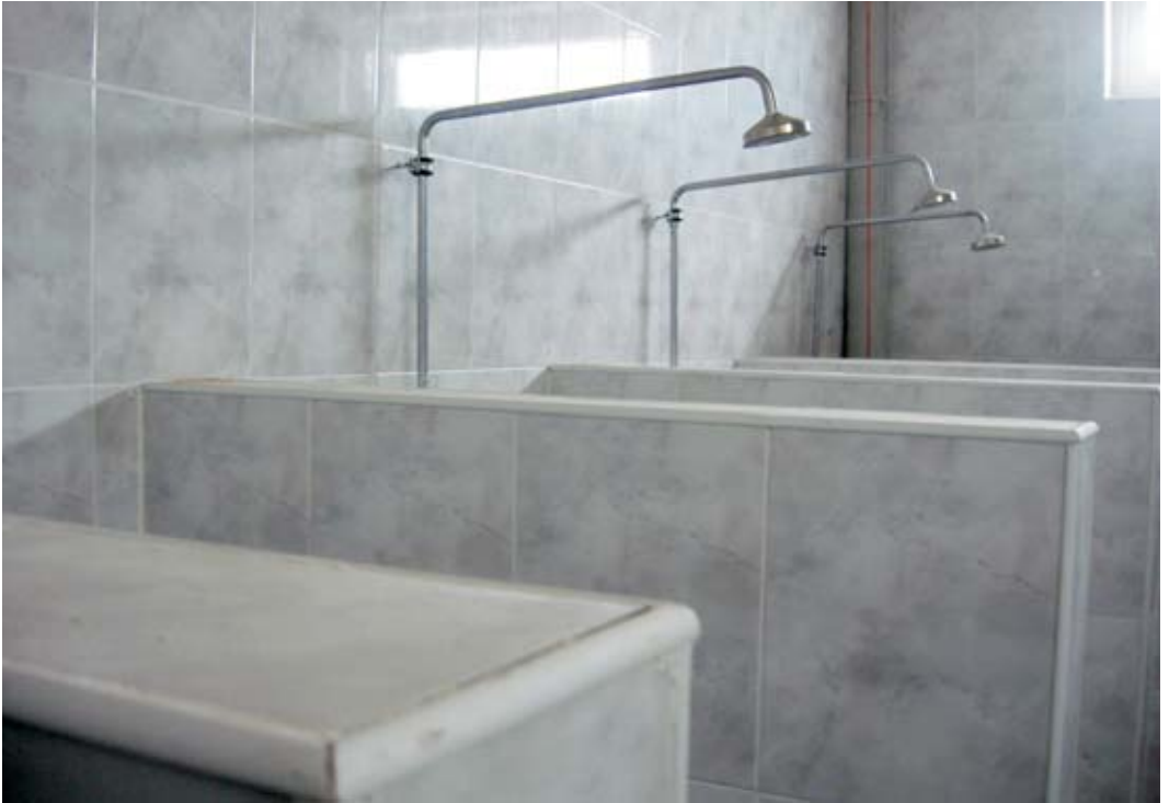
Şəkil 36. TN-nin Oğlanlar üçün açıq tipli xüsusi təlim-tərbiyə müəssisəsi. Yeni hamam.
